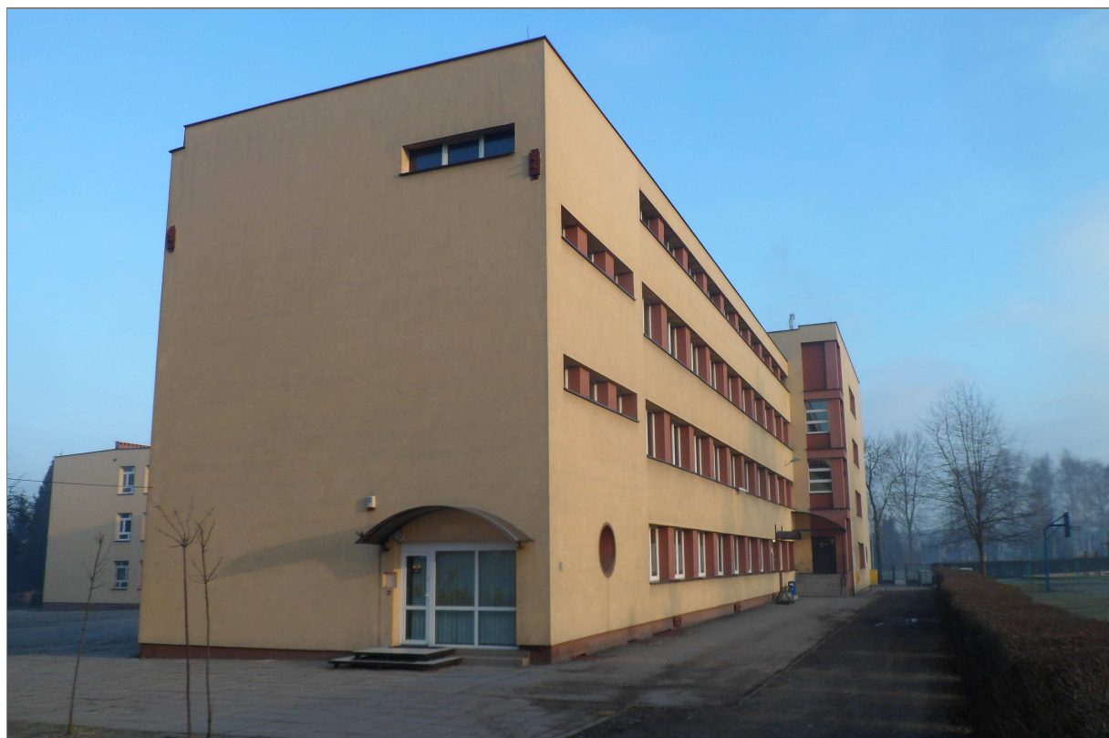
Przedmiotowy segment budynku przy ul. Paderewskiego 5
